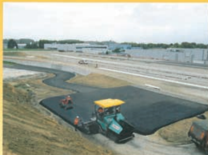
Da das Testgelände in vielen relativ kurzen Abschnitten hergestellt wurde, war der Fertiger trotz der großen Gesamtfläche im Alleingang unterwegs. Dabei durfte er während des Einbaus nicht stehen bleiben, eine perfekt organisierte Baustellenlogistik war ein Muss.
