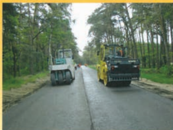
Bild 7: Verdichtung mit Gummiradwalze sowie Glätten mit Glattmantelwalze
