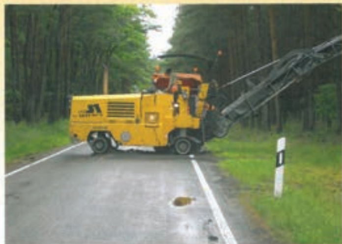
Bild 2: Auffräsen der Probenahmestelle auf der Landesstraße L 72
