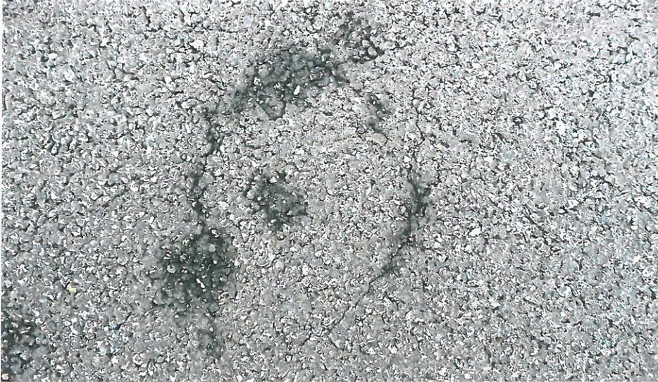
*Bild 5: ringförmig eingebrochene Blase im Splittmastixasphalt durch Verkehrsbelastung*
