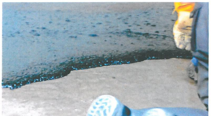
*Bild 7: Flüssigkunststoff-Dichtung, nach ca. 1 min werden kleine Blasen sichtbar*
