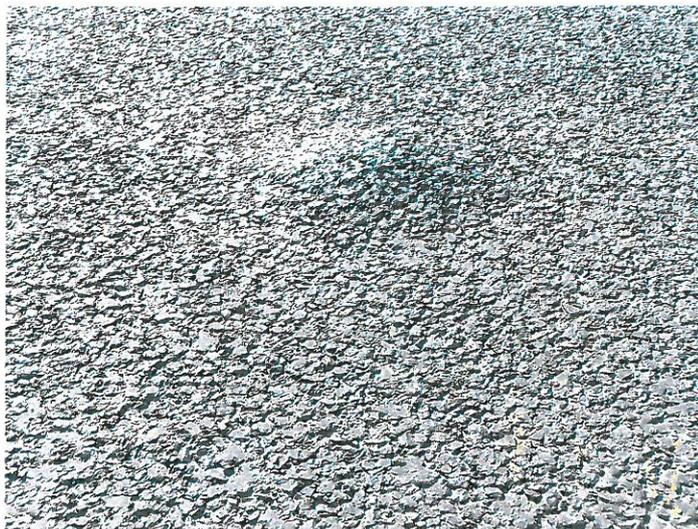
Bild 8: Blase unter SMA auf dichtem Binder mit porösen Einschlüssen
