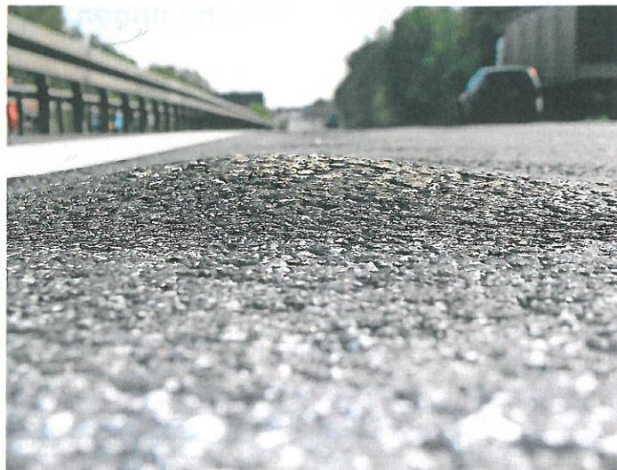
Bild 9: Blase unter dichtem Splittmastixasphalt auf SAMI über Beton bei einer Autobahnbaumaßnahme
