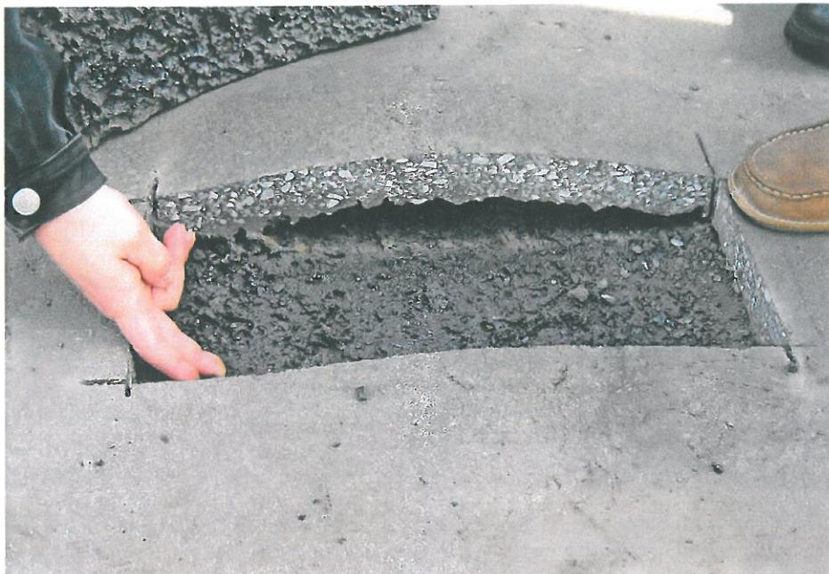
Bild 4: Blase infolge feuchtem Gestein (in der Pufferschicht einer Stahlbrücke)
