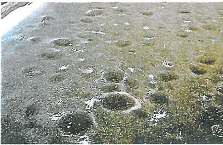
**Bild 3: Brückenoberfläche mit gehäuft auftretenden Blasen im Gussasphalt über alter Mastixdichtung**
