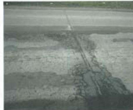
Bild 5: Schadbaute, mit Asphalt geflickte Kantenabplatzungen an Quersfugen sowie Netzrisse, resultierend aus Alkaliesäureschädigungen
